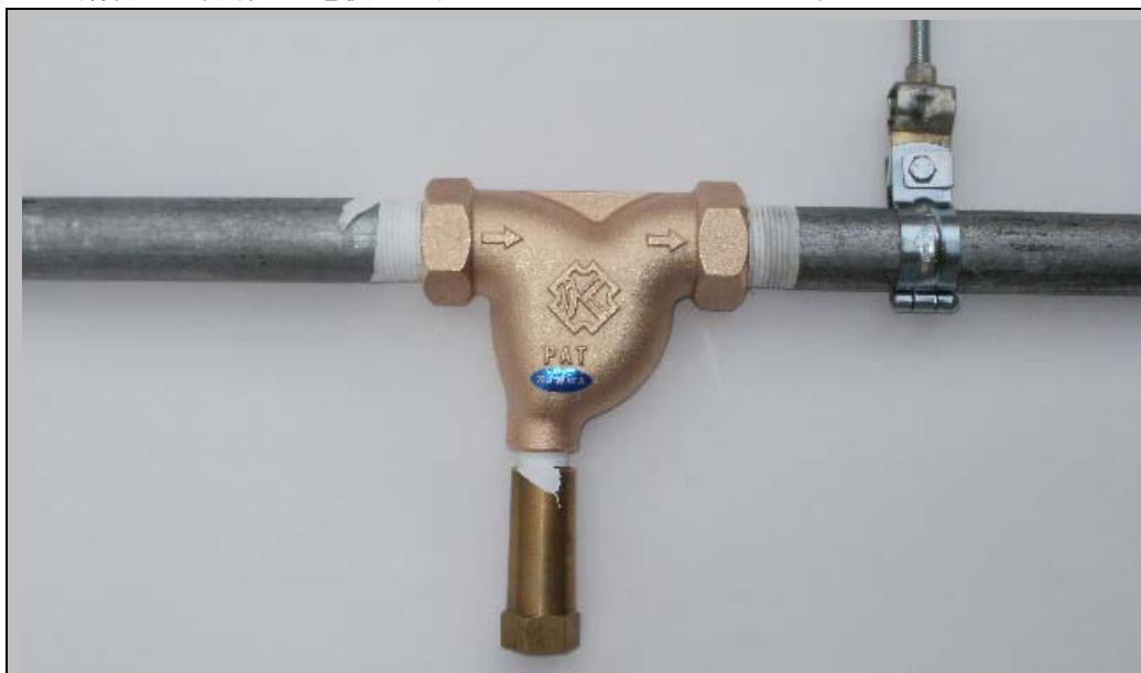
スプリン継手（K-101B）にプラグを取り付けた例
